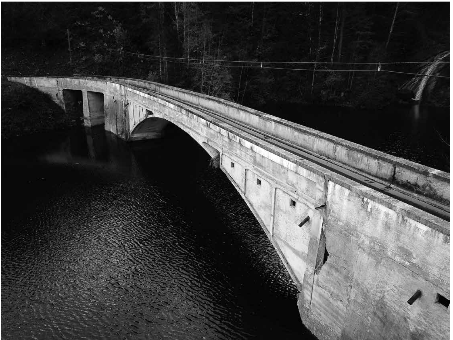
Die bald 100-jährige Schräbbachbrücke am Wägitalersee.
